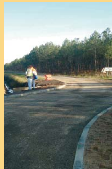
Travaux du pont situé sur la piste 245
